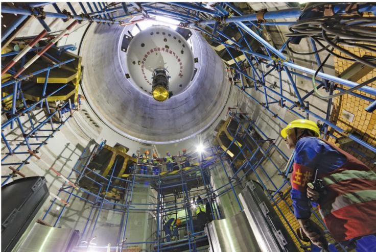
华能石岛湾高温气冷堆示范工程首台反应堆压力容器吊装就位。
