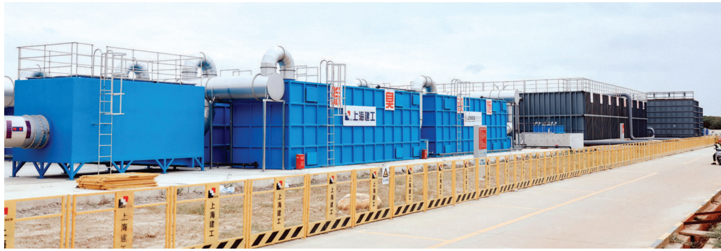
白龙港污水处理厂扩建三期工程现场。
