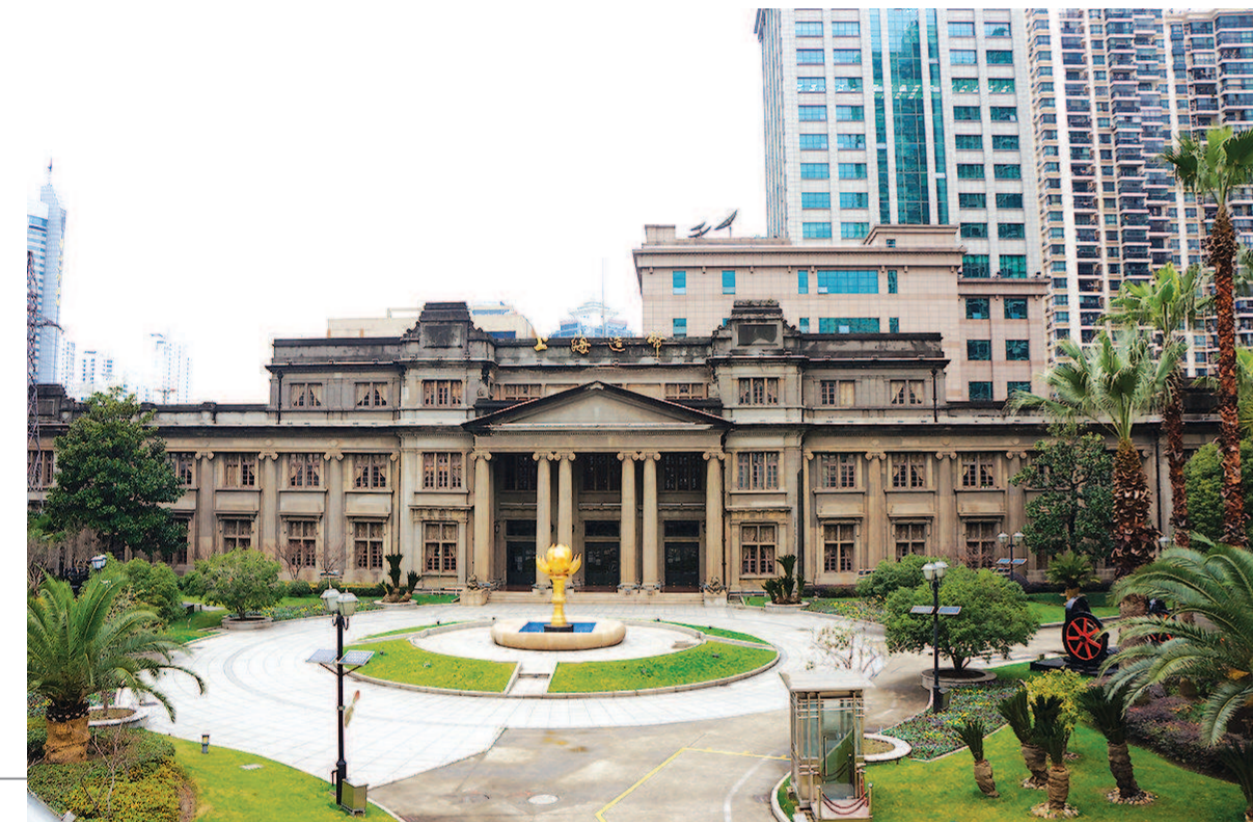
▲上海造币厂主楼
