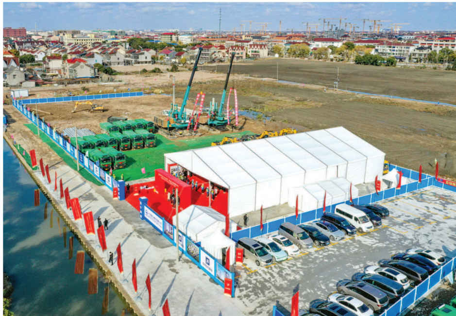
临港新片区2023年第一季度重点建设项目开工仪式在书院镇安置房五期主会场举行。 本报记者 邢千里摄
