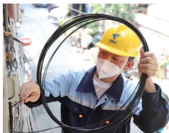
上海电信西区局装维人员细心维护线路 摄影 俞喆
