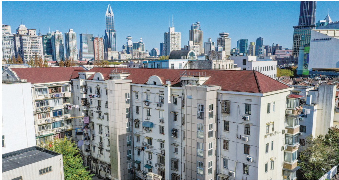
思南路26弄在年轻社工的努力之下,为小区实现了电梯加装工程的全面覆盖。
