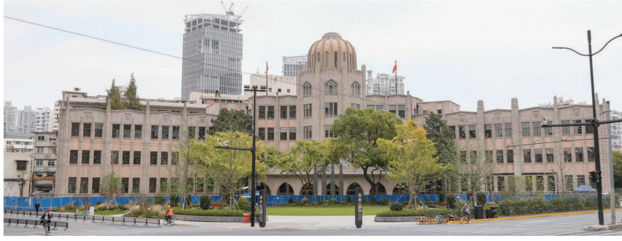
昨天，雷士德工学院建筑修缮工程整体完工。
