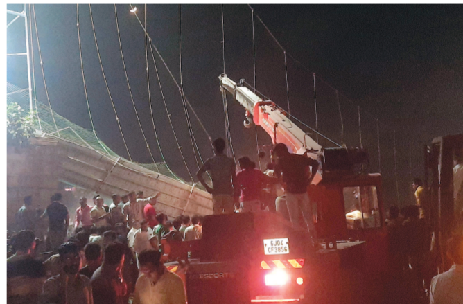
10月30日，人们在印度古吉拉特邦莫比地区桥梁断裂事故现场进行救援。新华社发
