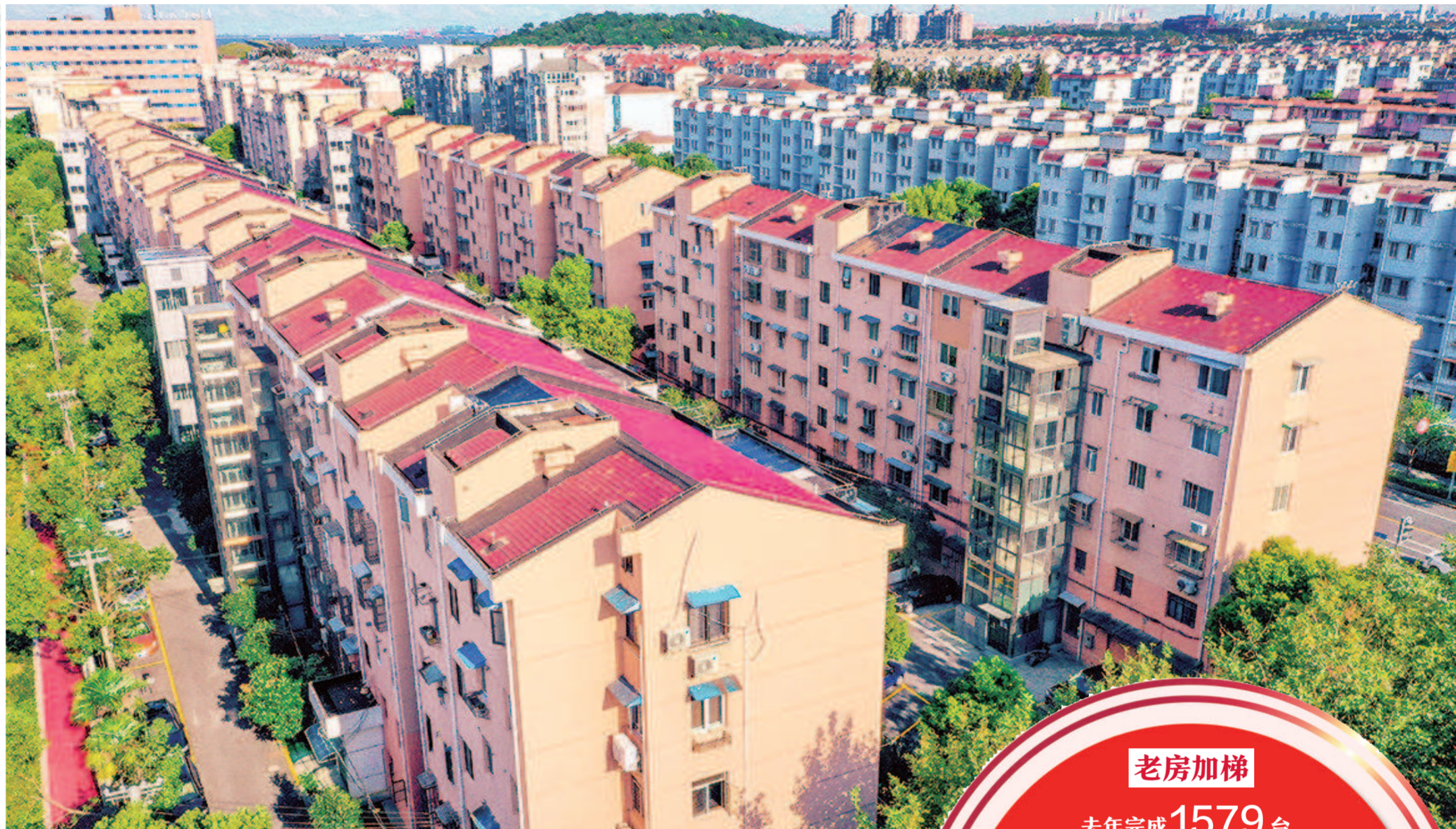
宝山九村小区多幢住宅楼加装电梯方便社区居民出行。 本报记者 邢千里摄
