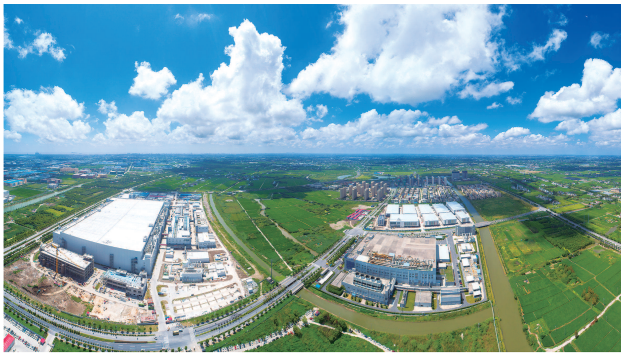
上海湾区高新区新型显示产业企业和辉光电厂房。
