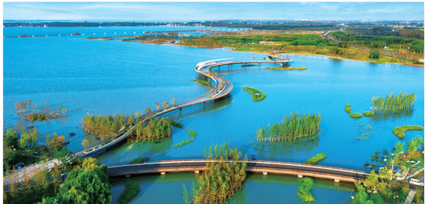
元荡岸线生态修复及功能提升(三期)工程近日在上海青浦、苏州吴江同时开工,将于年底前实现元荡岸线整体贯通。
