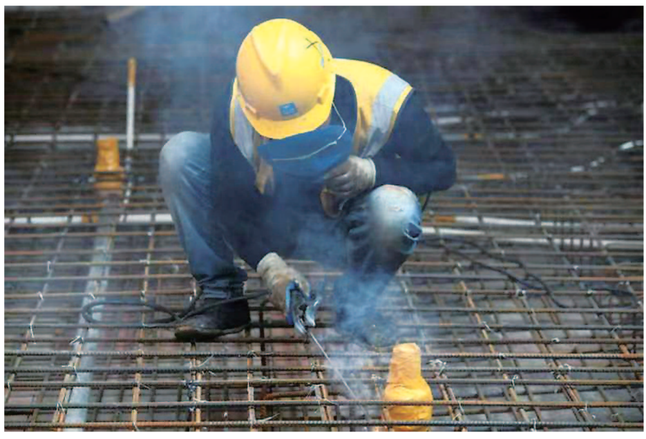
在中建八局安康苑一期建築工地上,工人在烈日下施工。
