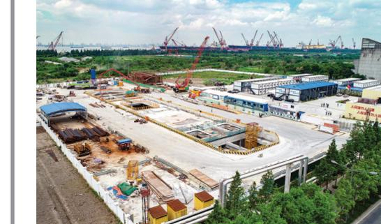
近日,上海轨道交通崇明线108标大小盾构转换段主体结构工程顺利封顶,成为崇明线工程中首个结构封顶的单位工程。上海市轨道交通崇明线是连接上海中心城区和崇明两岛(长兴岛、崇明岛)的市域轨道交通线,全长约43公里。108标工程实现主体结构封顶,为后续13米超大盾构穿越长江成功筑牢了脚点,更为轨道交通崇明线全线工程建设持续推进创造有利条件。图为建设现场。 本报记者 张晓明 张伊辰摄影报道
