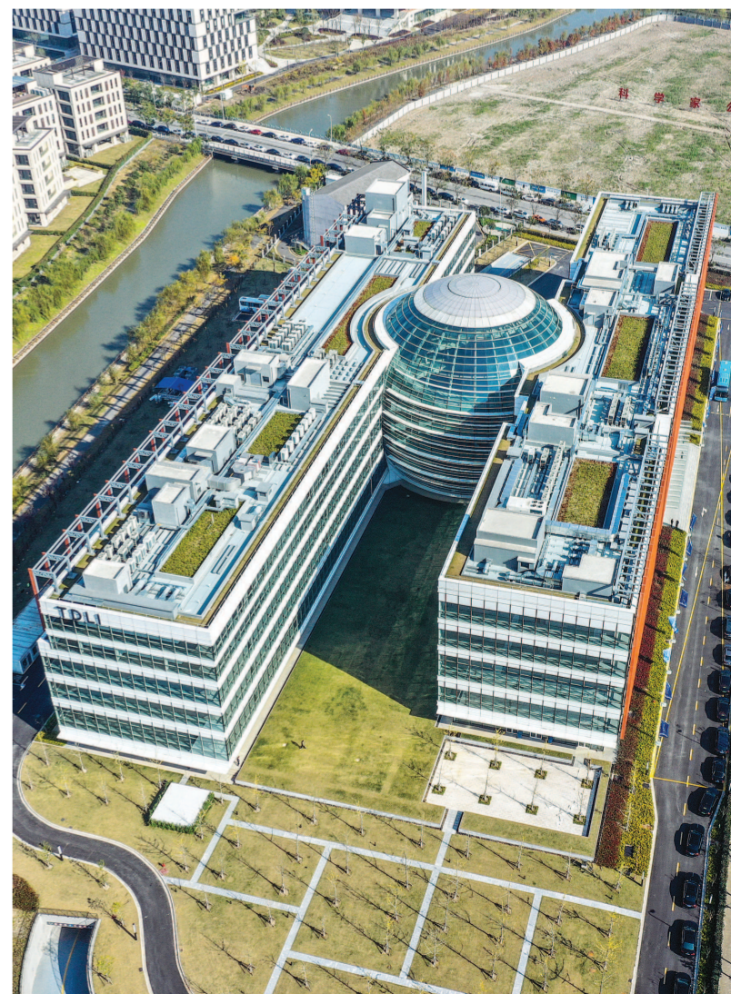
上海交通大学李政道研究所实验楼。
