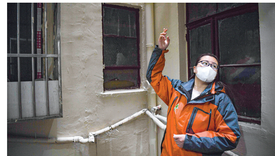
龚顺美在东新支路55弄小区查看居民楼内的内天井。 本报记者 张伊辰摄
