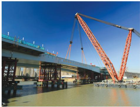
吴淞江大桥东幅桥完成主桥钢箱梁合龙段吊装。
