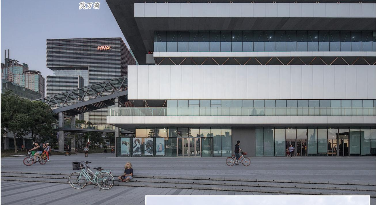
▲建筑与结构团队为屋顶旧有的两排柱子“戴”上一个四边外挑的钢结构桁架，而楼下各层新增楼板则通过垂直钢拉杆层层下挂。这一巧妙的做法既避免了新增基础作业，又依托了原有结构的存在。
