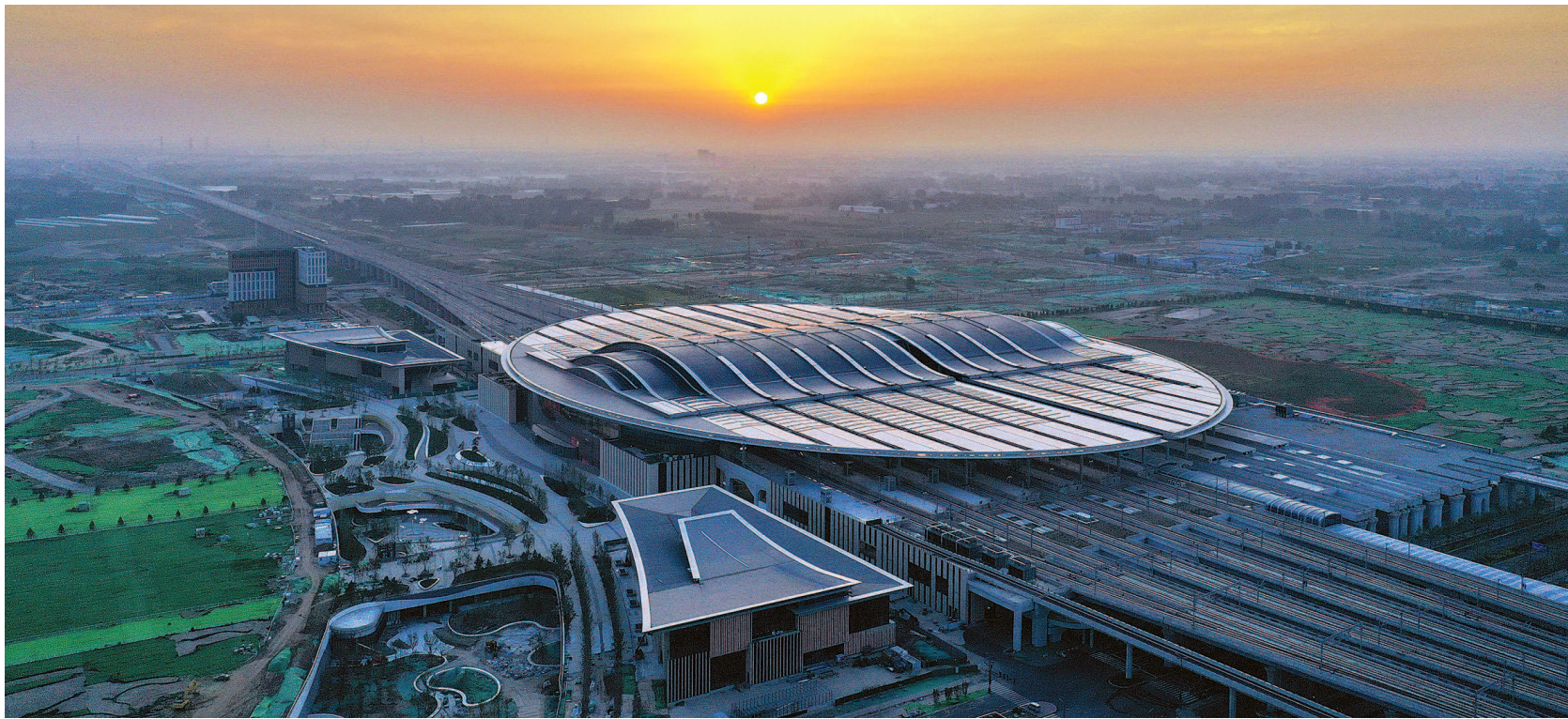
7月1日拍攝的京雄城際鐵路雄安站（無人機照片）。
