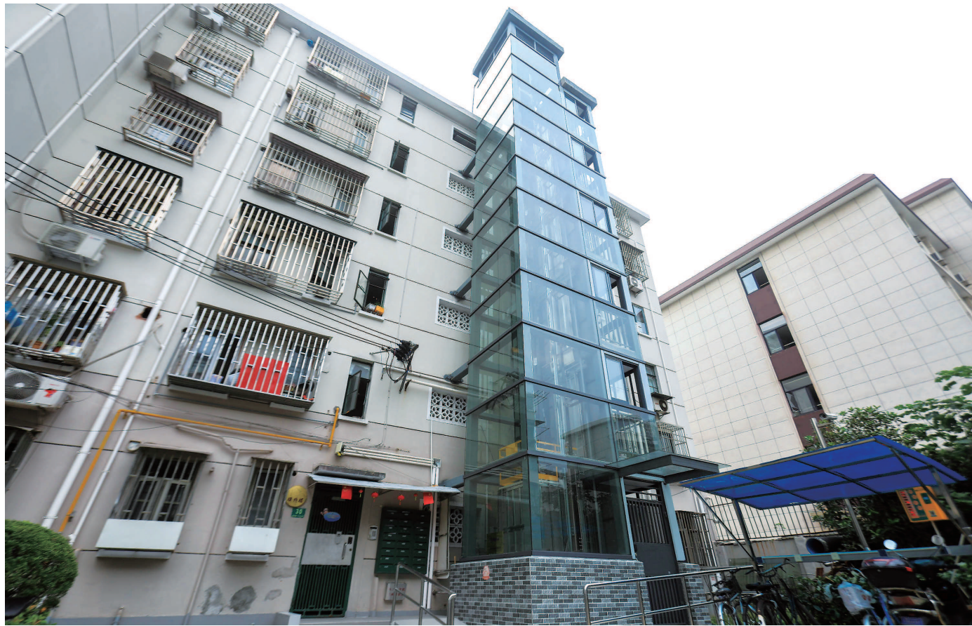
彭浦新村街道闻喜路1000弄30号加装电梯后,居民生活更加便捷。
