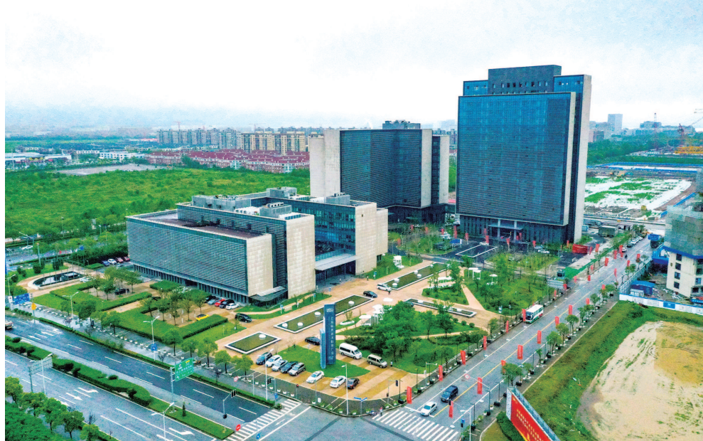
临港新片区未来将形成3到5个千亿级产业集群。图为不久前竣工的海洋创新园·海科广场（二期）项目。
