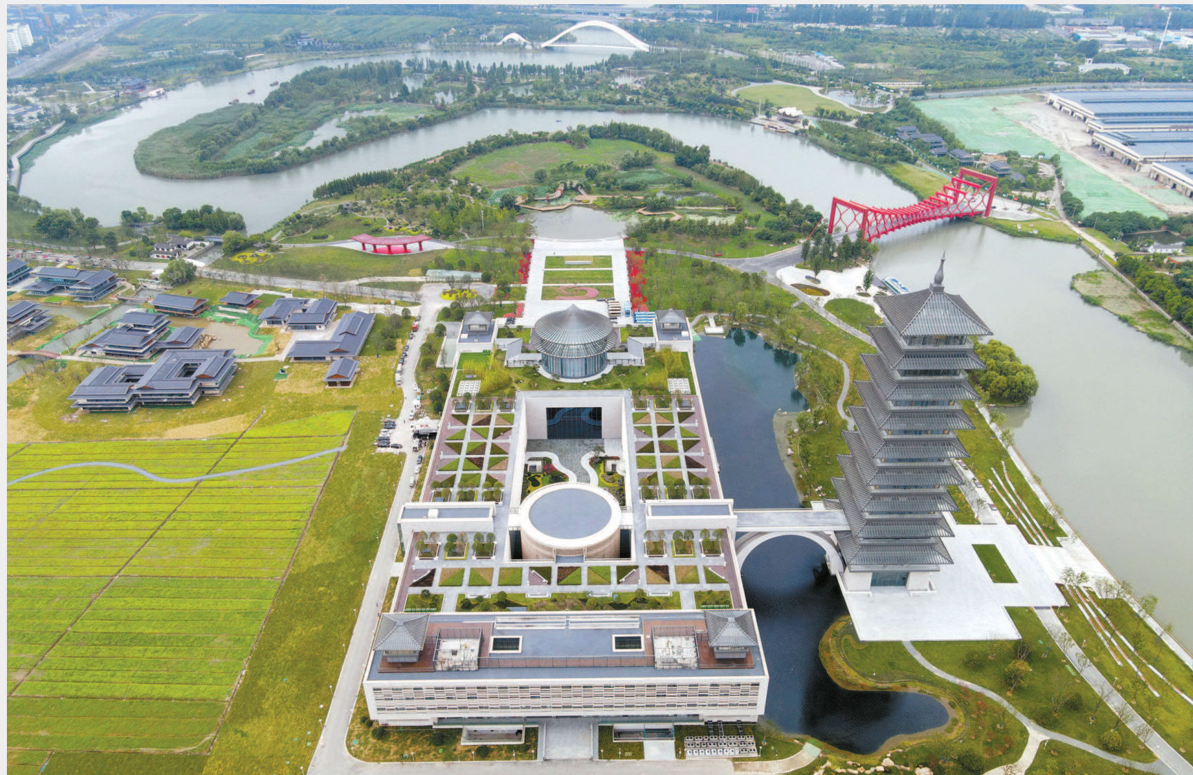
▲中国大运河博物馆,坐落于江苏扬州市运河三湾生态文化公园内。
