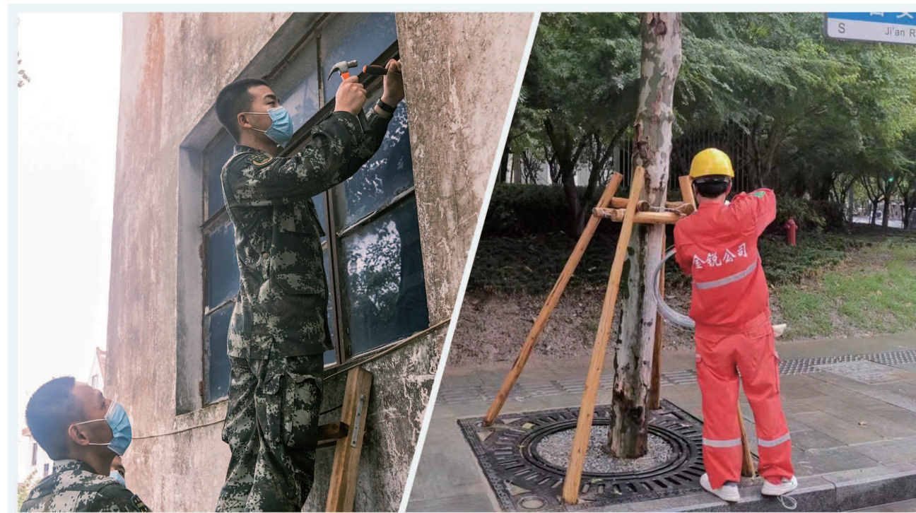
武警官兵为村民维修房屋。
