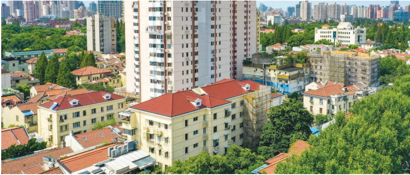
乌中小区加装电梯工程如火如荼进行中。
