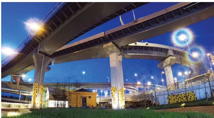
苏州河中环桥下空间更新项目。
