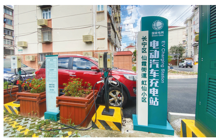
虹仙小区内的电动汽车充电桩。本报见习记者 张天弛摄
