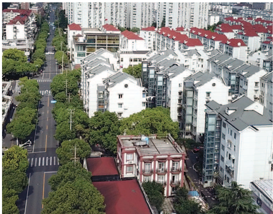
上海老房加梯再提速,越来越多老房子安上新梯展新颜。
