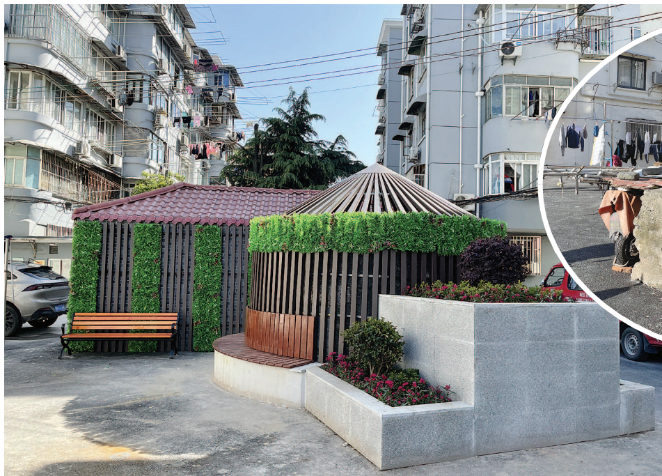
在石泉路180弄，居民区党总支组织居民将小区内一处违建透景进行了改造，共建新合并小区的文化地标。图为改造前(上图)后(左图)的景观。
