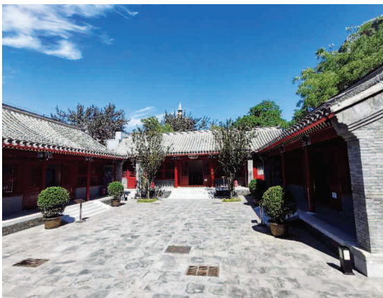
沈家本故居二进院。现东西厢房已开辟成展厅，北房设为会议室。
