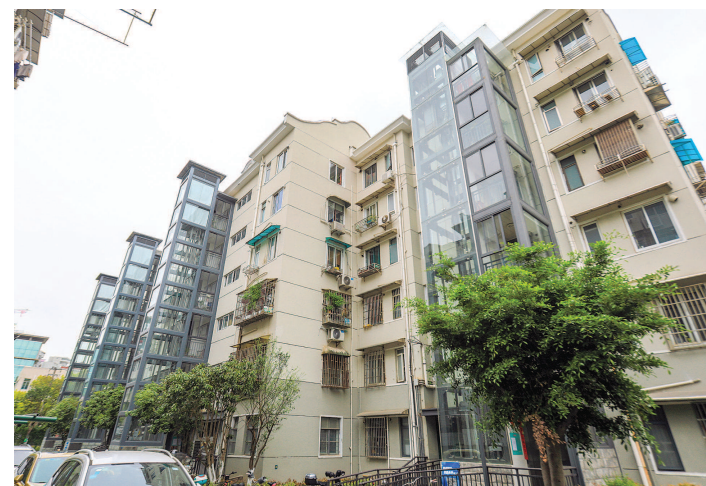
静安区临汾路街道首创物业“建管一体”新模式,让辖区居民在加装电梯后使用更安心。本报记者 叶晨亮摄
