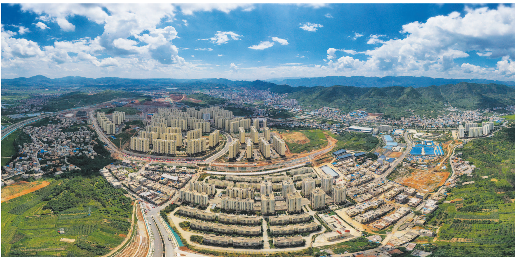
云南昭通鲁甸易地扶贫搬迁安置区的全景照片。
