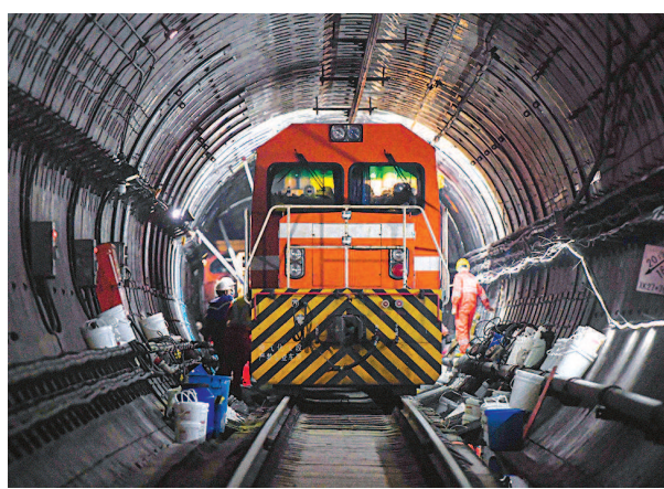
地铁7号线杨高南路站至高科西路站单向隧道临时停运整修工程施工现场。 本报记者 张伊辰摄
