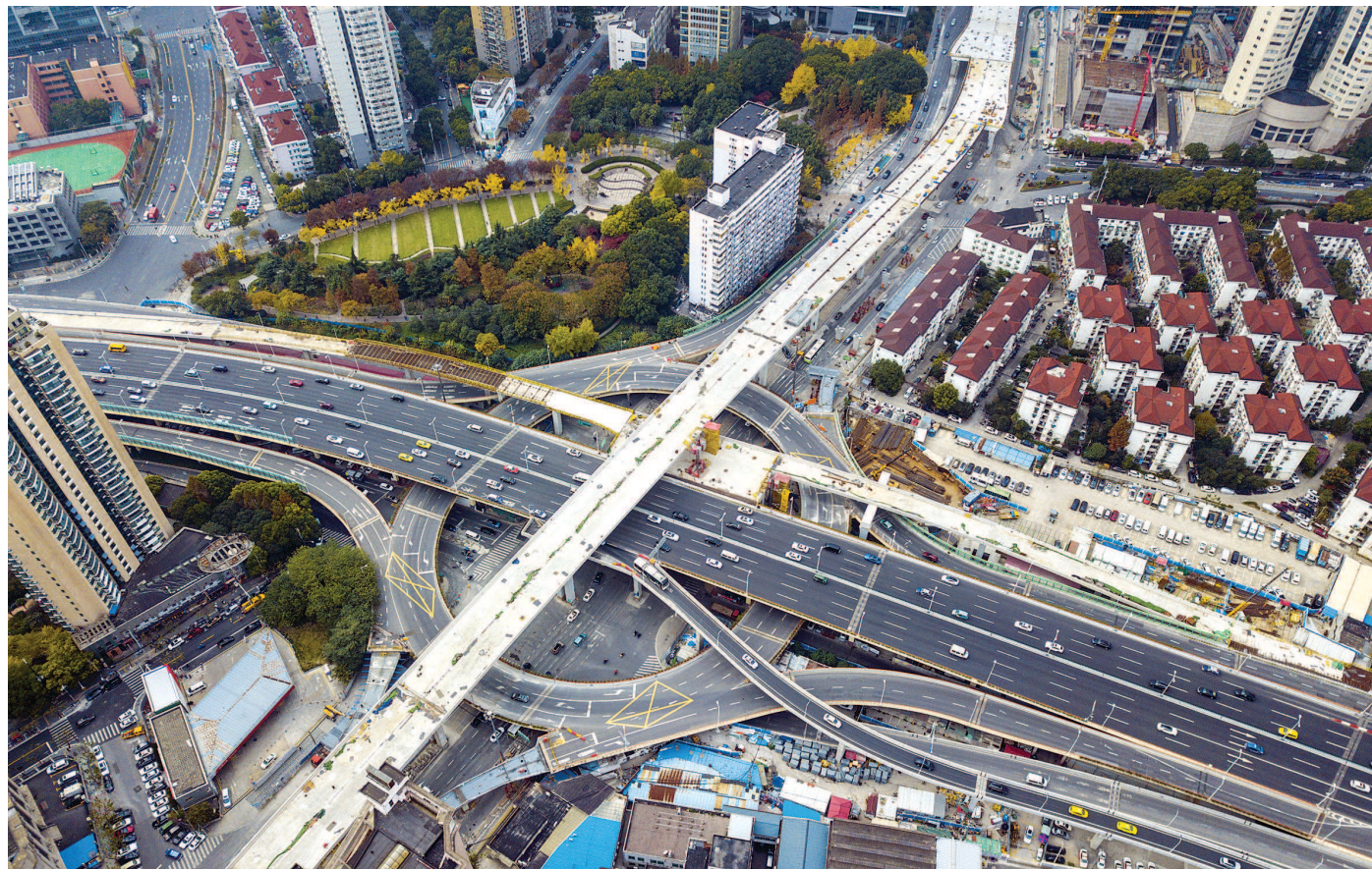
北横通道西段工程航拍图。
