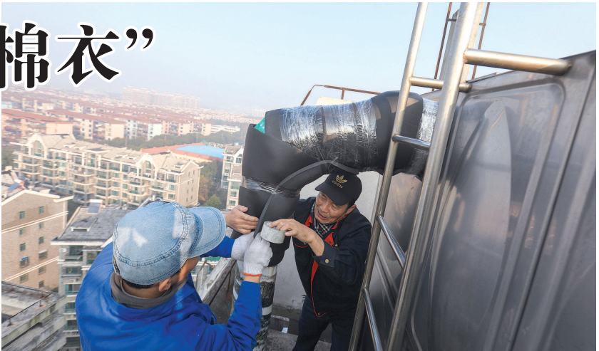
昨天,四季绿城小区物业工作人员登上屋顶,为水箱进出水管捆扎保温材料,未雨绸缪防止低温冰冻影响居民生活用水。本报记者 叶辰亮摄
