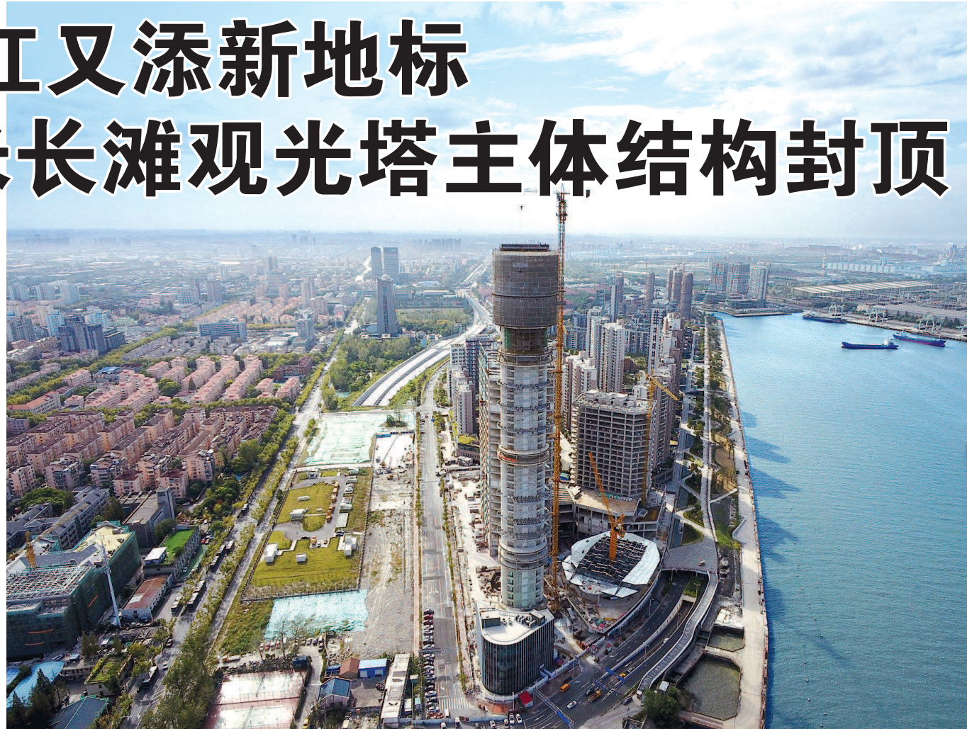
位于宝山滨江的上海长滩观光塔昨天顺利完成主体结构封顶。
