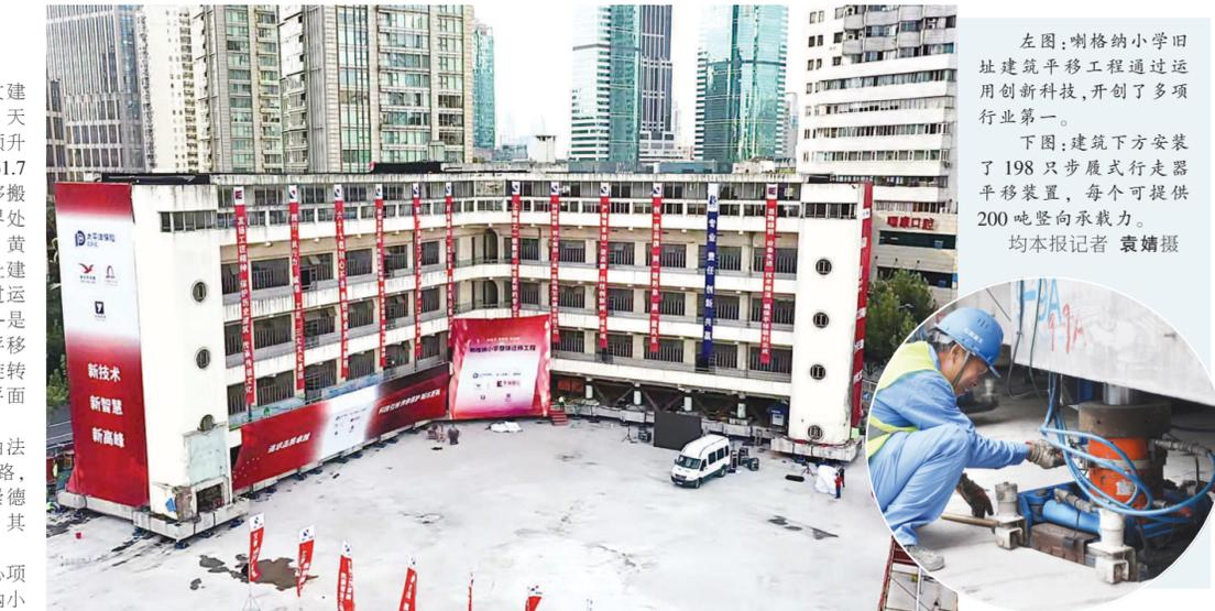
左图：喇格纳小学旧址建筑平移工程通过运用创新科技，开创了多项行业第一。右图：建筑下方安装了198只步履式行走器，每个可提供200吨竖向承载力。均本报记者 袁婧摄
