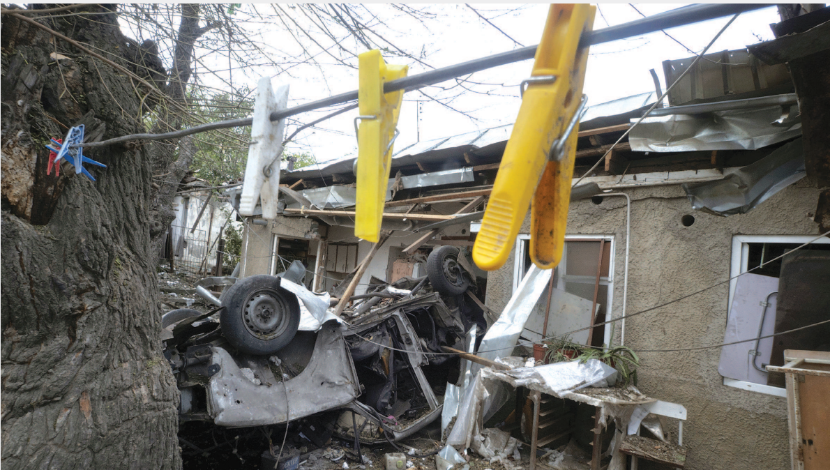
这是10月9日在纳卡地区首府斯捷潘纳克特拍摄的建筑废墟。
