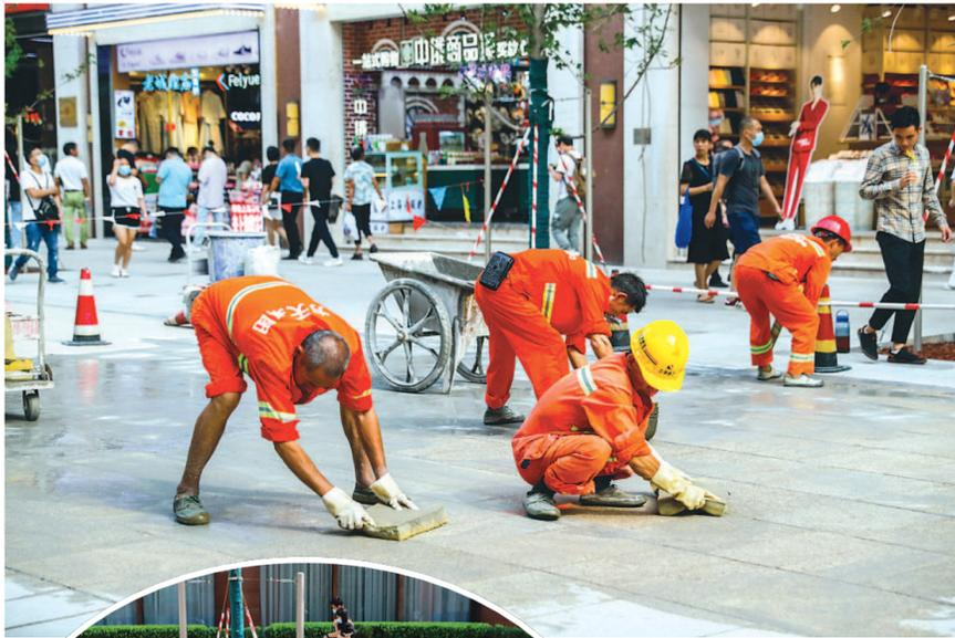
施工人员冲洗擦拭地面、填平地缝,为将最美南京路呈现给游客进行最后的细节完善。
