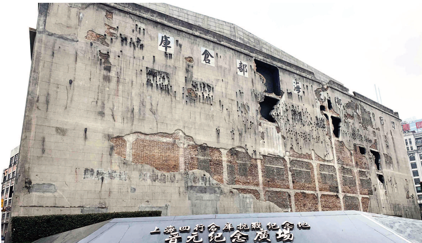
经过修复，四行仓库西墙共保留了8个炮弹孔、430个枪弹孔，再现淞沪会战悲壮历史。
