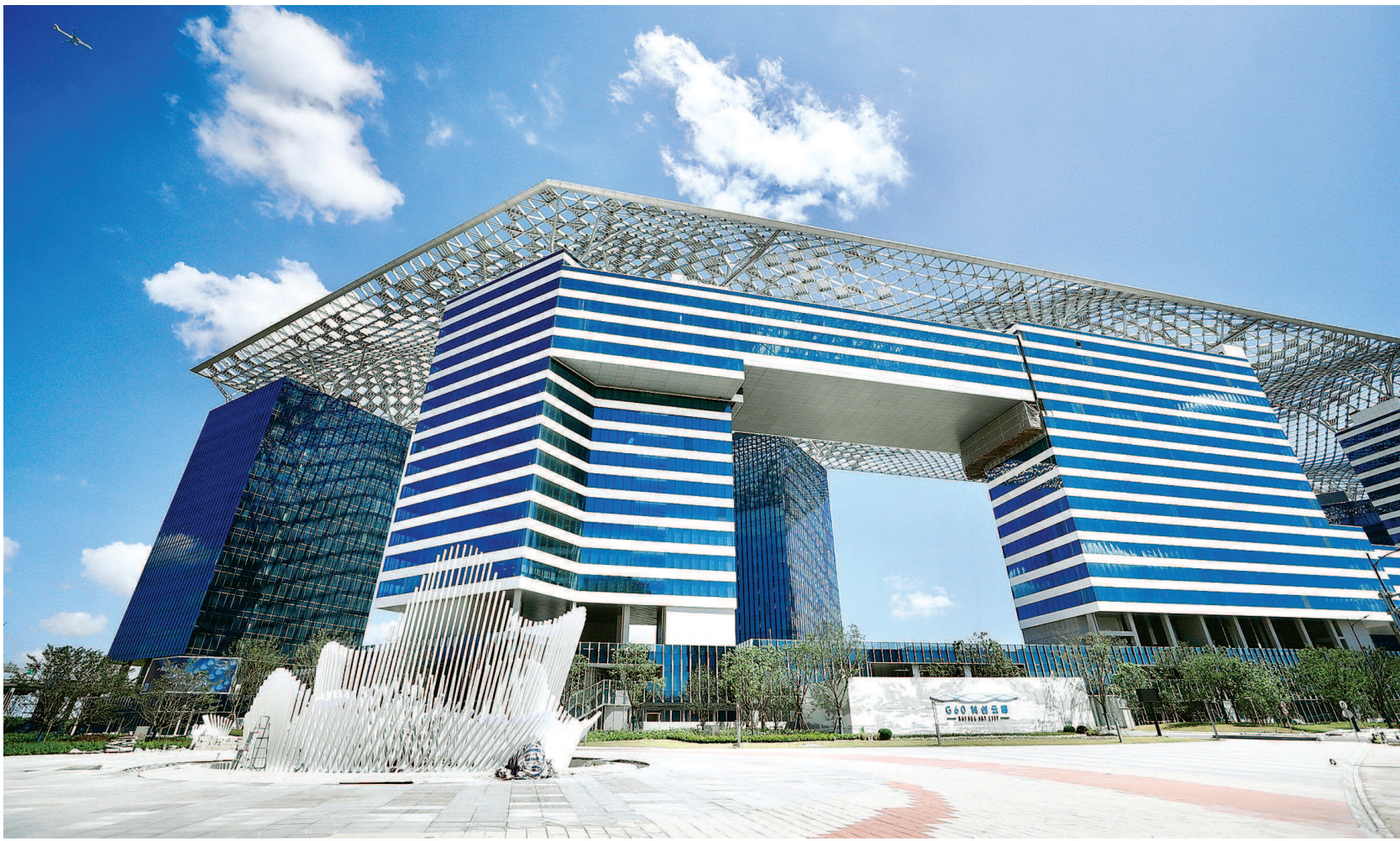
正在建设中的G60科创云廊已初见雏形。
