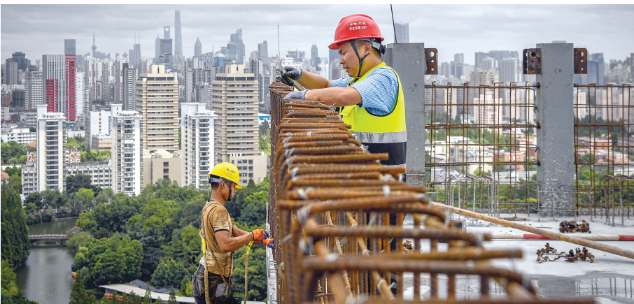
昨天,在中建三局华东公司国浩长风城项目建筑工地现场,安全监督员与工人加固外围钢筋和悬挑架体,防止大风导致高空坠物等隐患。 本报记者 陈龙摄
