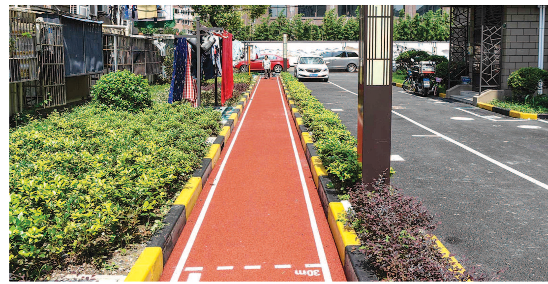
经过“美丽家园”工程建设,凉城四村的道路、绿化都进行了修整,真实呈现了“道路焕新颜,楼道增光明,地下管更新,绿化换新容”。居民们表示,小区健身设施一应俱全的新面貌,让他们感受到了实实在在的获得感、幸福感。 本报记者 陈龙摄
