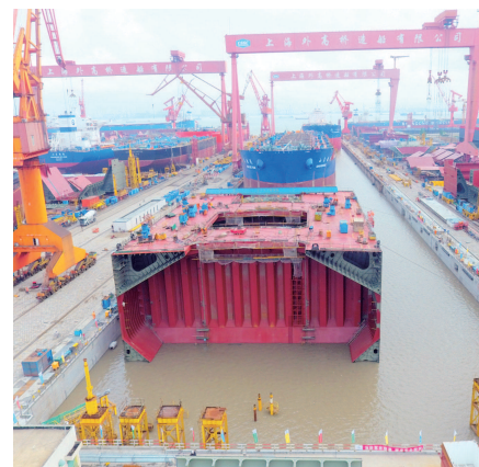
外高桥造船厂2号船坞。（中交三航局供图）
