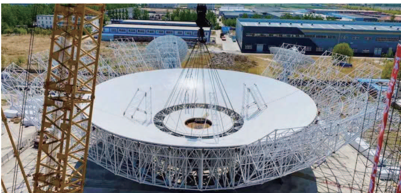
反射体正在被吊装上天线。
