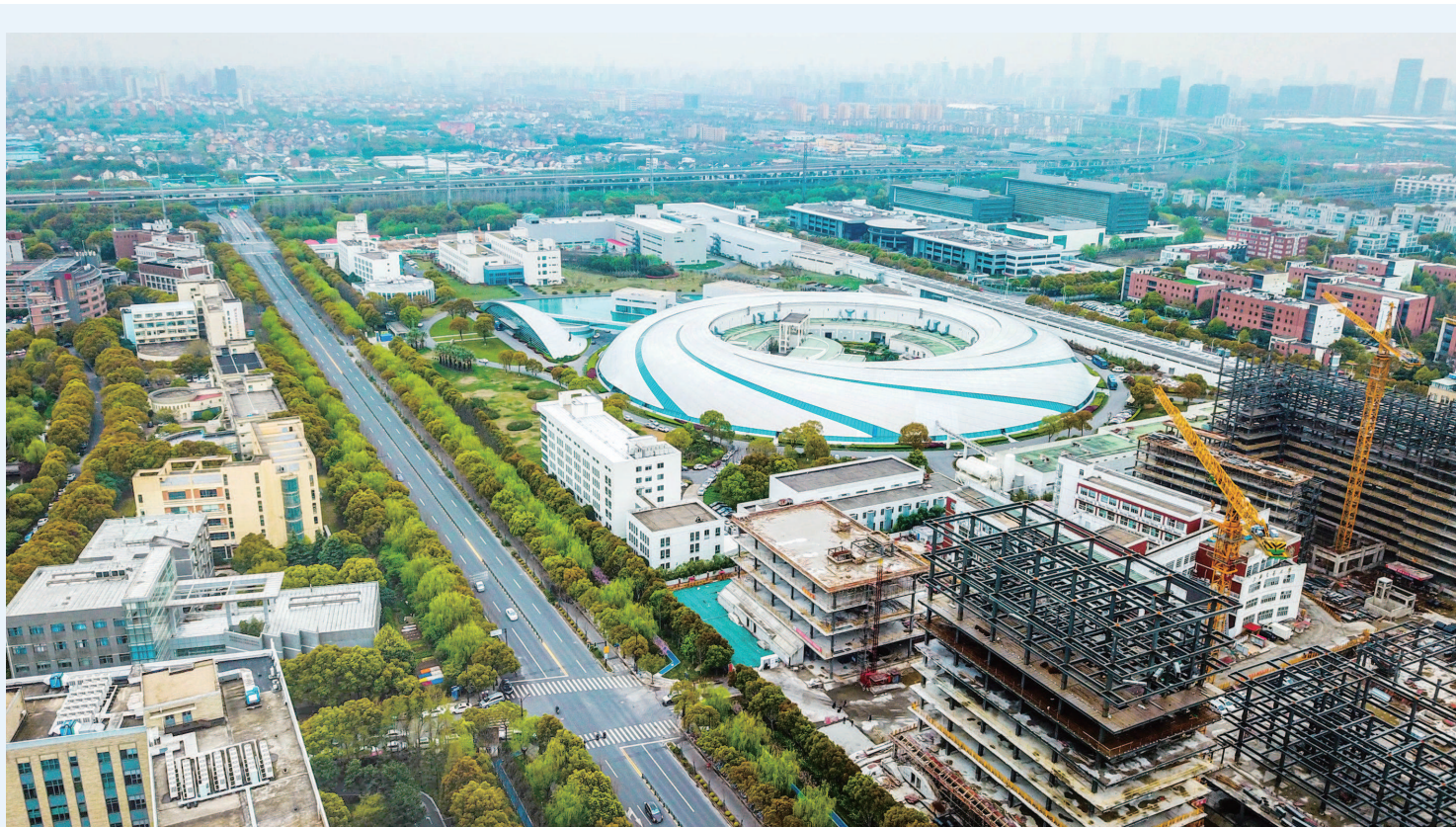
图为张江科学城已经全面复工，大科学装置在建工程项目正精准有序推进，部分建筑已经完成结构封顶。 本报记者 袁婧摄
