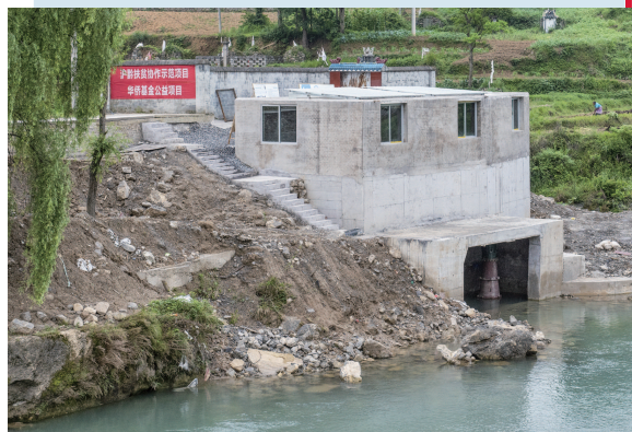
自然能提水设备泵房。（本版照片均淼汇科技提供）
