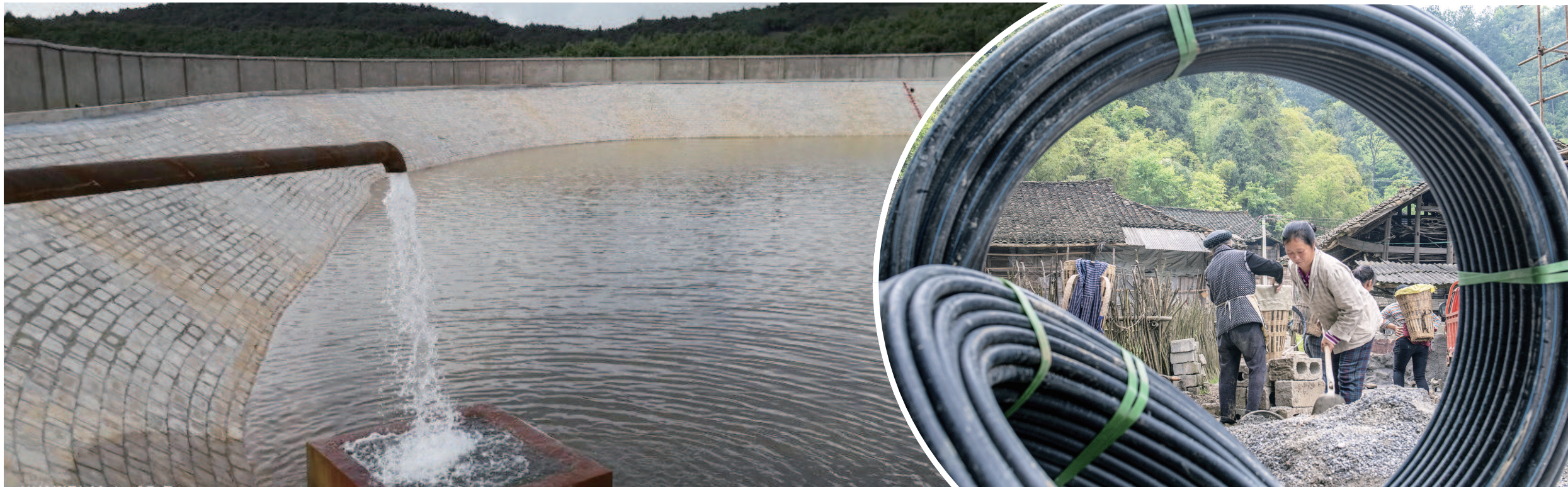
▲云南省弥勒市东山镇自然能提水工程出水。
