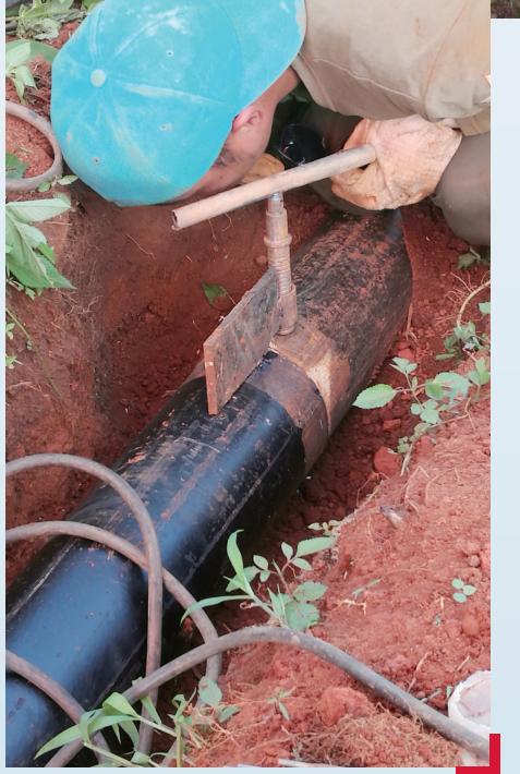
工人在铺排提水管道。
