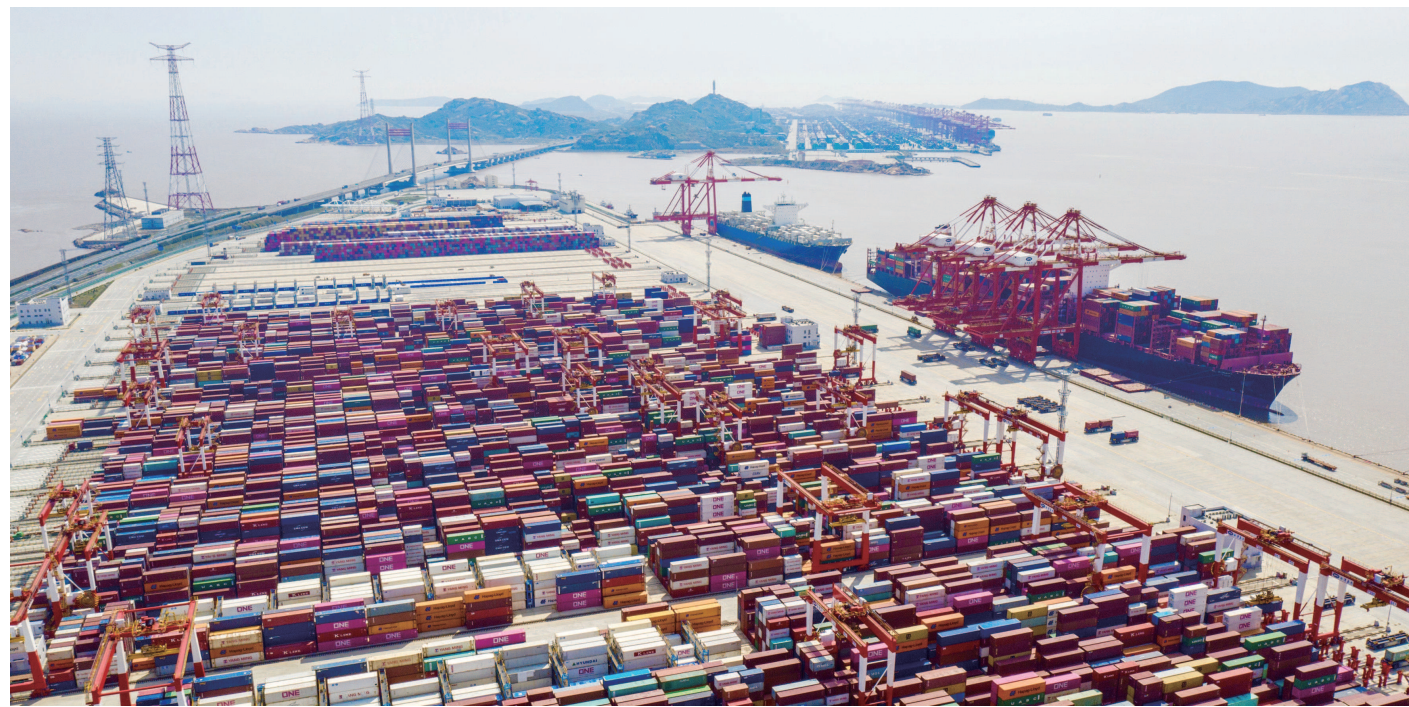
3月以来,洋山港日均集装箱吞吐量快速攀升,目前已恢复到正常水平的90%。
