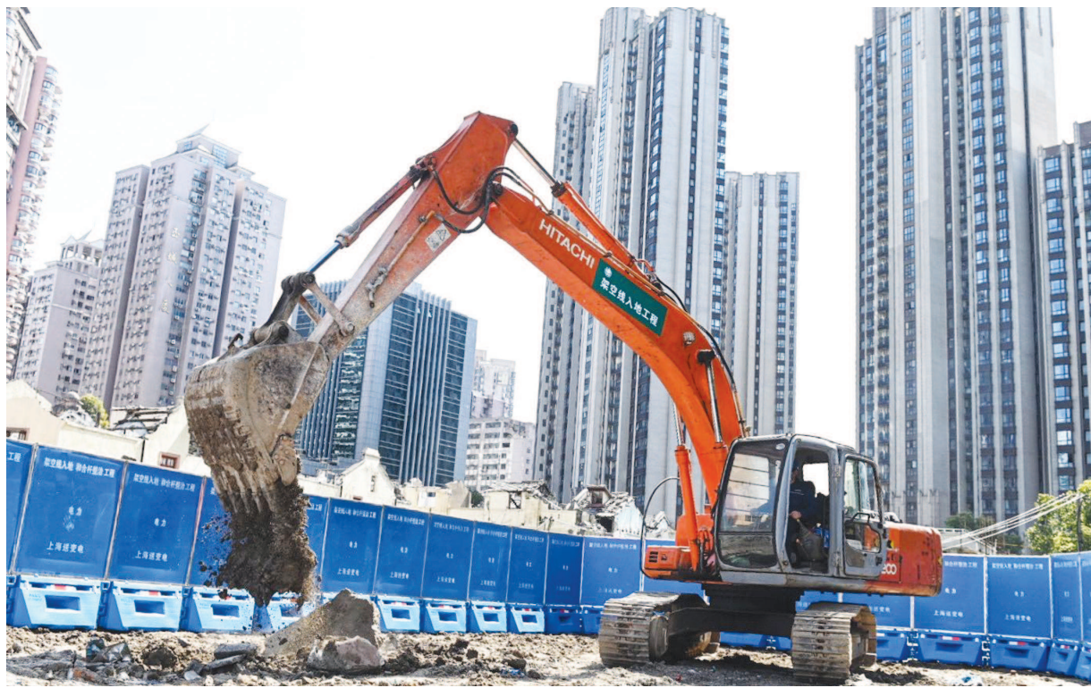
昨天,长寿路架空线入地工程正式开工。此次率先开工的长寿路(万航渡路—长寿路桥)工程,路段全长约2.63公里,沿线用地以商业、住宅及教育为主。(市住建委供图)
