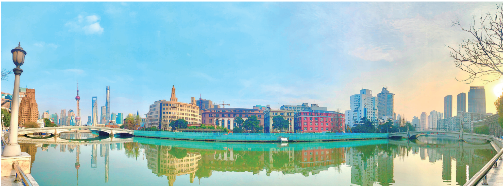
昨天起,苏州河公共空间景观提升工程正式复工。
