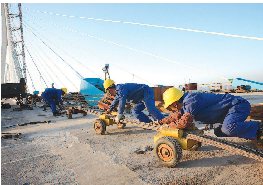
▲2019年11月15日，施工人员在沪通长江大桥主航道桥28号墩最后一组斜拉索吊装现场忙碌。
