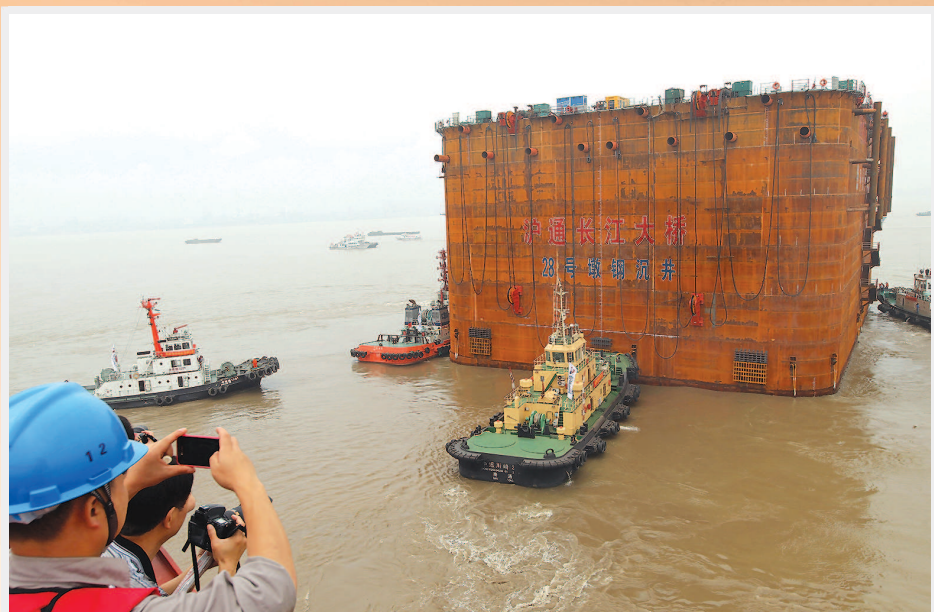
▲2014年6月22日，沪通长江大桥第28号墩沉井当天从船坞启运，经过多艘拖轮顶托约11公里后顺利抵达桥址。该沉井平面尺寸相当于12个篮球场大小，高度达115米，是世界上规模最大的深水沉井基础。
