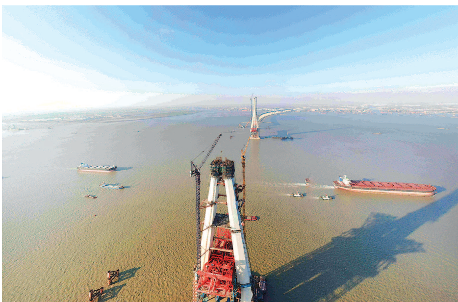
▲2018年12月28日，沪通长江大桥南岸主塔成功合龙，这是该桥在主航道桥施工过程中取得的又一次重大突破。
