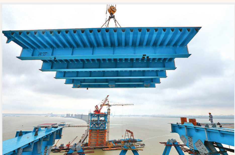
▲2016年8月26日，沪通长江大桥天生港专用航道桥正式进入钢桁梁双悬臂拼装阶段。航道桥主跨336米，通航净空宽度284米，净空高度45米，是目前世界上同类型结构中最大跨度的公铁两用钢拱桥。
