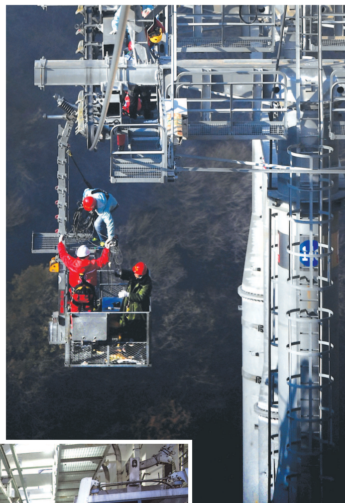
▲检修人员对索道支架及钢丝绳进行检测。
