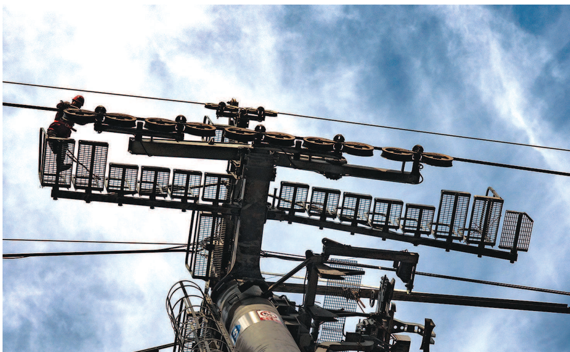
▲检修人员在进行支架横担检测。 ▲检修人员在进行走台焊接。 ▼检修人员在进行索道托索轮检测。
