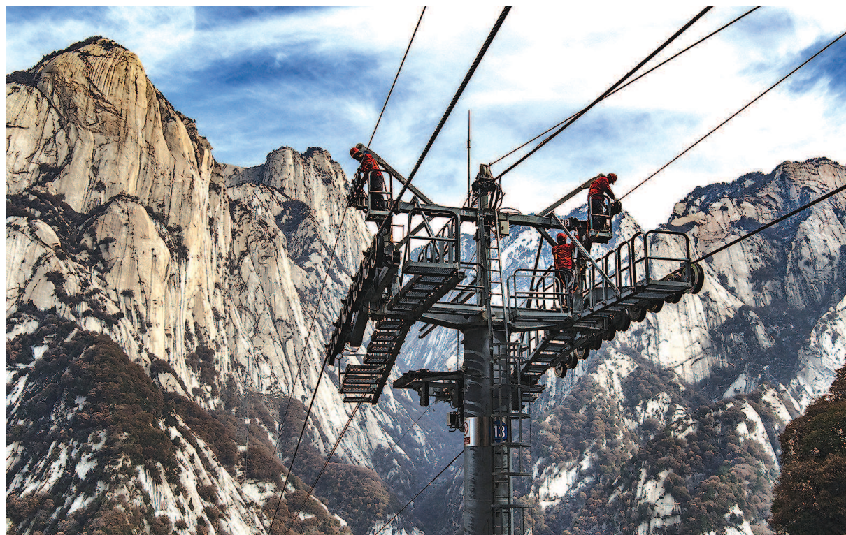
▲检修人员在进行支架横担检测。 ▲检修人员在进行走台焊接。 ▼检修人员在进行索道托索轮检测。
